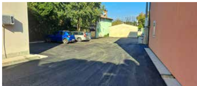
▲ Asfaltirano parkiralište u Pomeru
