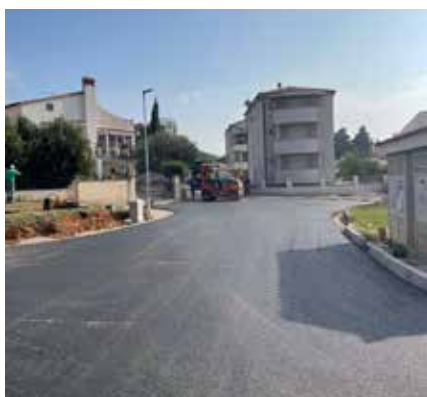
▼ Kapovica – Krase – Fucane asfaltiranje i javna rasvjeta
