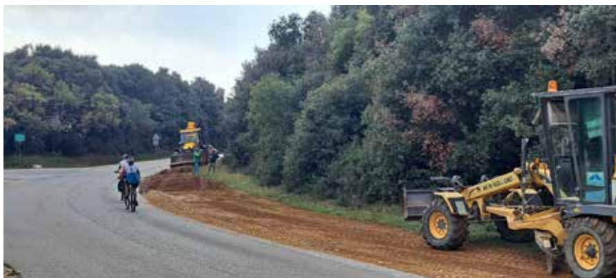
◀ Sanacija vododerine Pješćana Uvala
