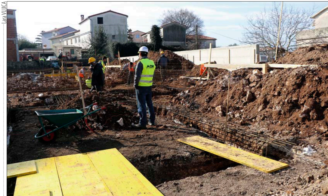
U veljači je postavljen kamen temeljac za izgradnju Dječjeg vrtića Pomer, a otvorenje je planirano za rujan ove godine
