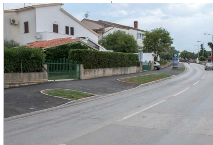
Na Munidi je nastavljena izgradnja nogostupa prema Burlama
