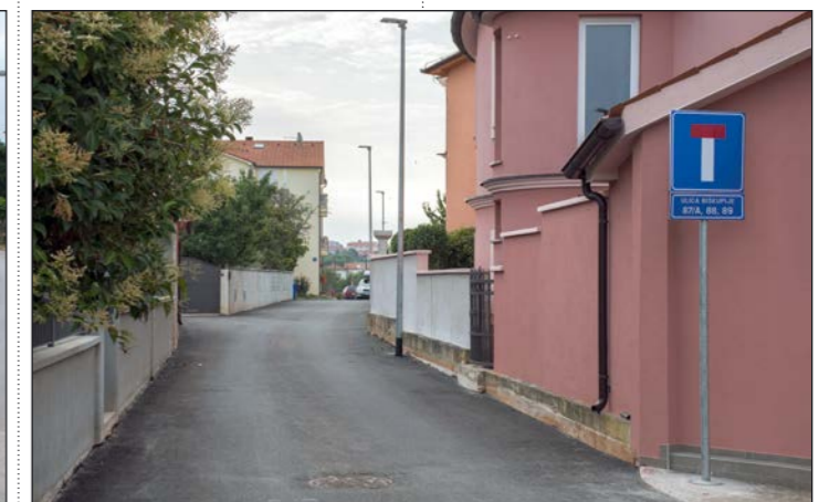
U Biškupiji je izgrađena i asfaltirana prometnica s kompletnom infrastrukturom u dužini od 95 m
