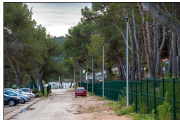
Izgradnja javne rasvjete uz cestu prema AC Pomer
