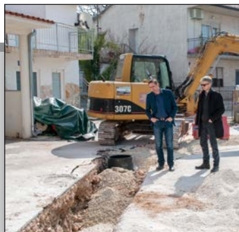
U Medulinu se gradi kanalizacija i nova vodovodna mreža str. 10-11
