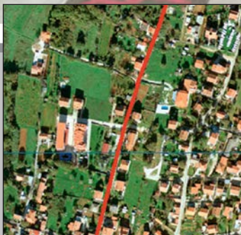
Gradi se kanalizacija u Medulinu, Pomeru, Banjolama i Premanturi str. 6-7
