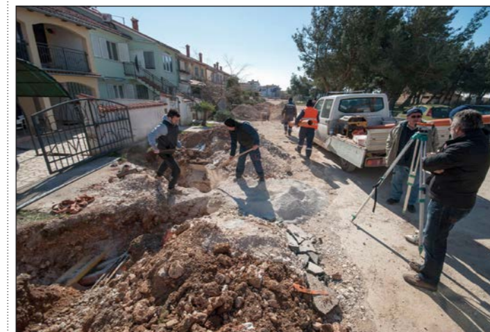
Izgradnja kanalizacijskog i vodoopskrbnog sustava u Banjolama
