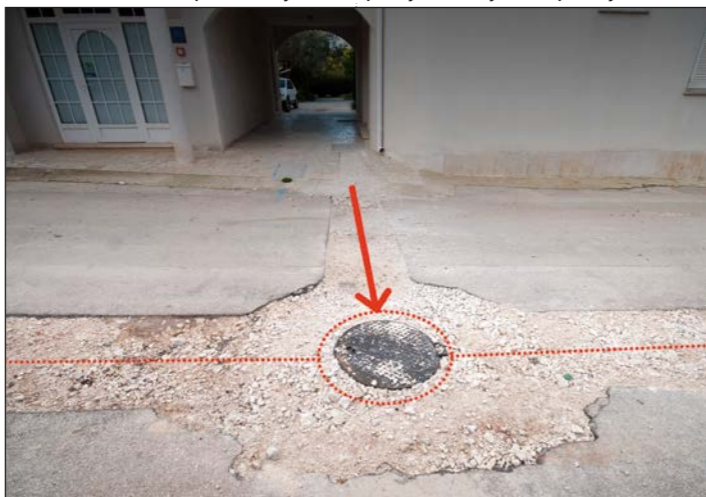
Kućni priključak na reviziono okno
