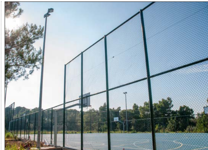
Postavljena nova rasvjeta na igralištu u Premanturi
