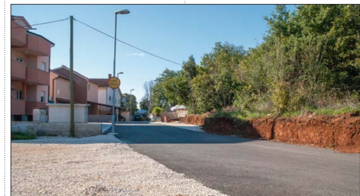
Novouređena prometnica s javnom rasvjetom u ulici Kazali u Medulinu
