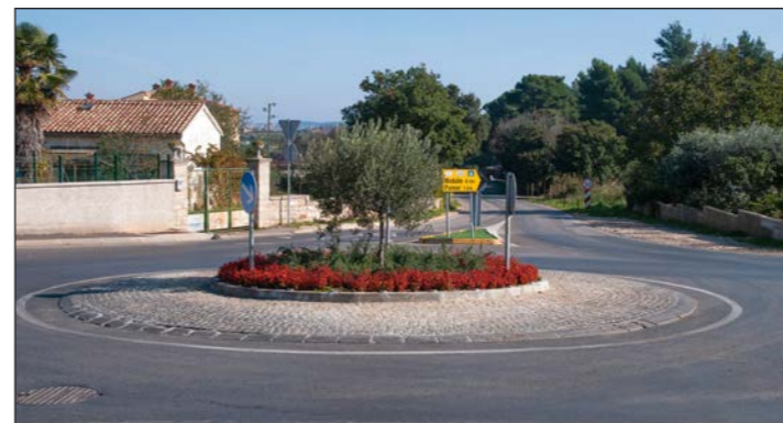
Novouređeni kružni tok na Kamiku
