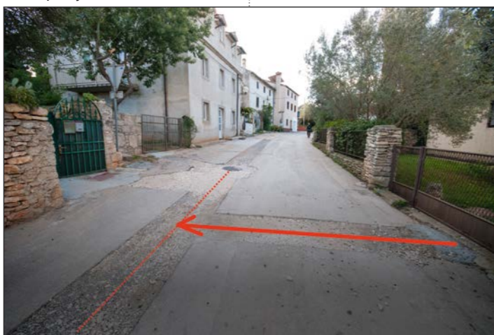
Kućni priključak na glavni kolektor
