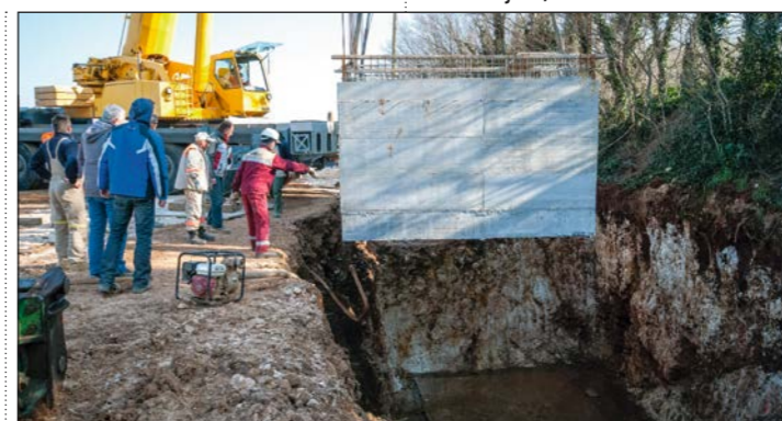
Postavljanje crpne stanice PUČ u Pomeru
