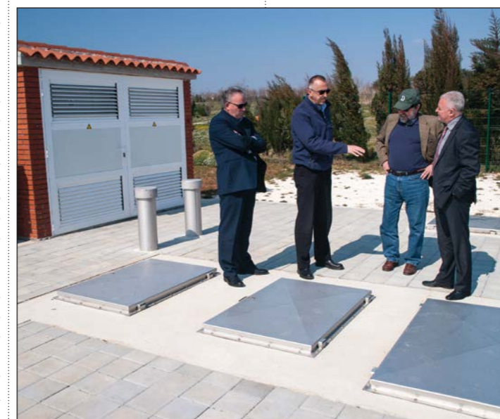
Crpna stanica Kažela
