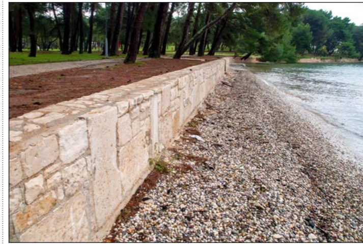
Novo izgrađeni potporni zid i uređena plaža na Klementovici u Medulinu
