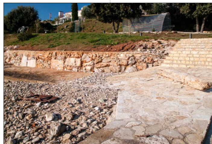
Potporni zid i uređeno sunčalište u Pješčanoj Uvali
