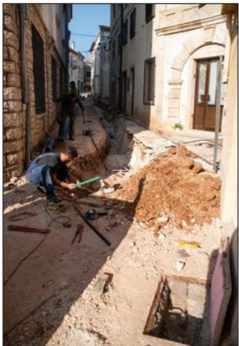
Izgradnja fekalne i vodovodne mreže u staroj jezgri Medulina
