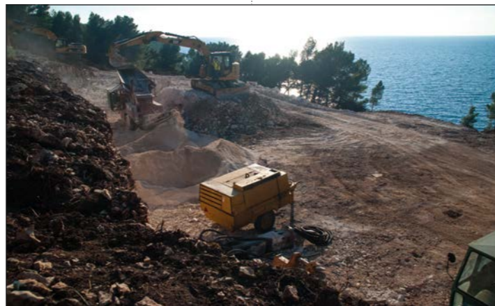
Izgradnja UPOV-a Premantura s ispustom u more
