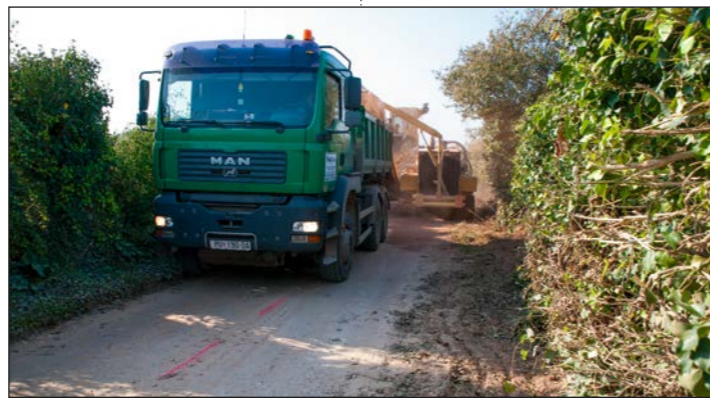
Radovi na gravitacijskom kolektoru u Pomeru
