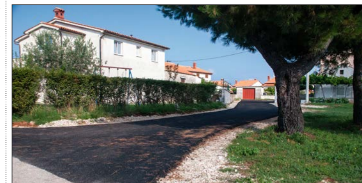
Novouređena prometnica u naselju Dvorine u Banjolama
