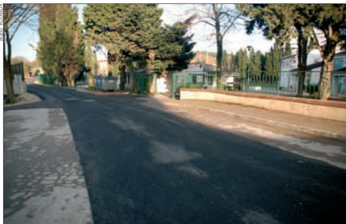
Uređena je i asfaltirana pristupna cesta vrtiću u Medulinu
